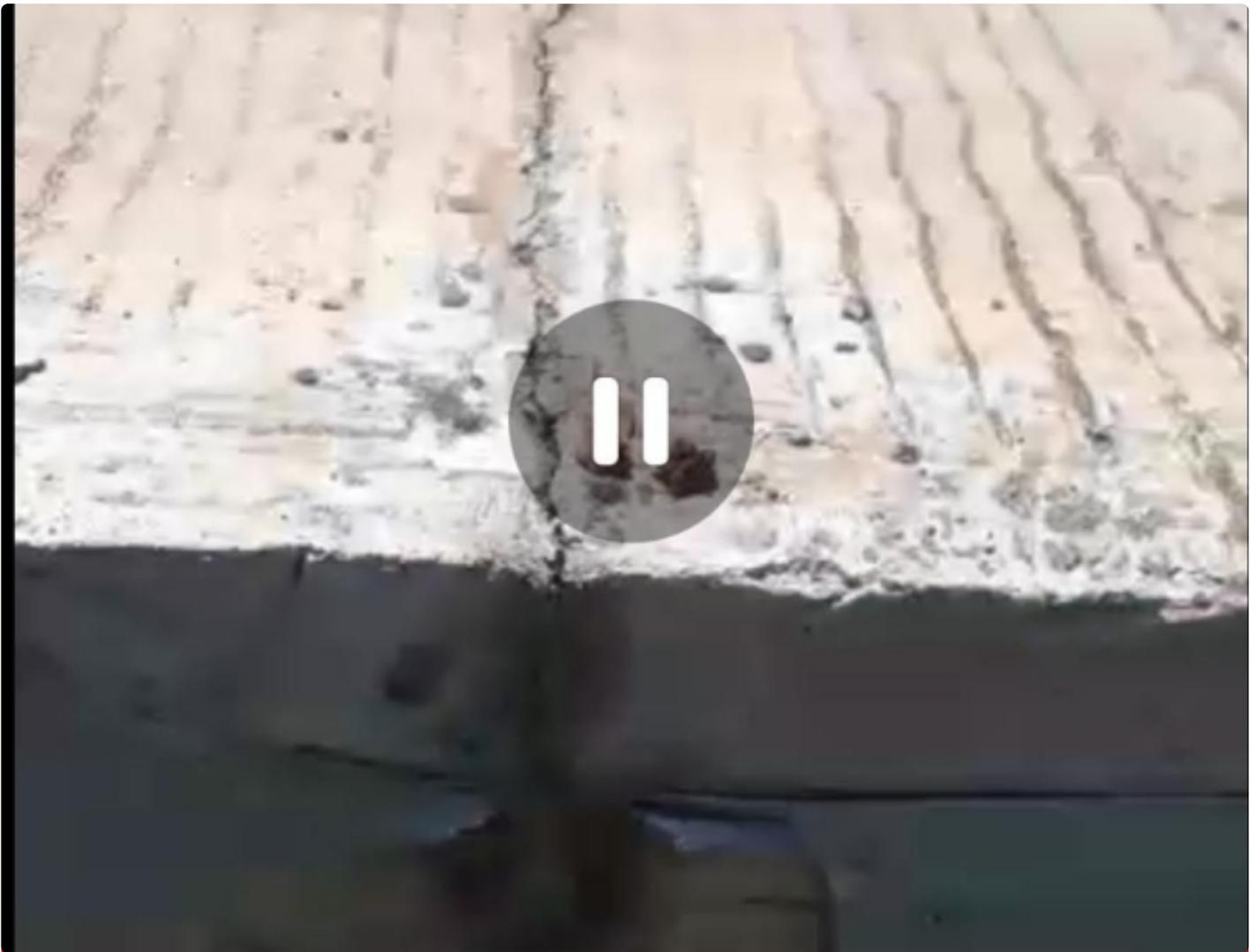
*(Foto dok Indonesiasatu.co.id) Terlihat kondisi patah di salah satu segment jalan Putat Nutug-Kuripan Kec.Ciseeng*
